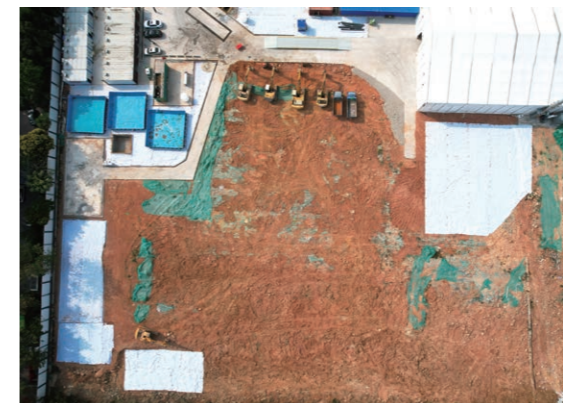
环境治理项目现场
